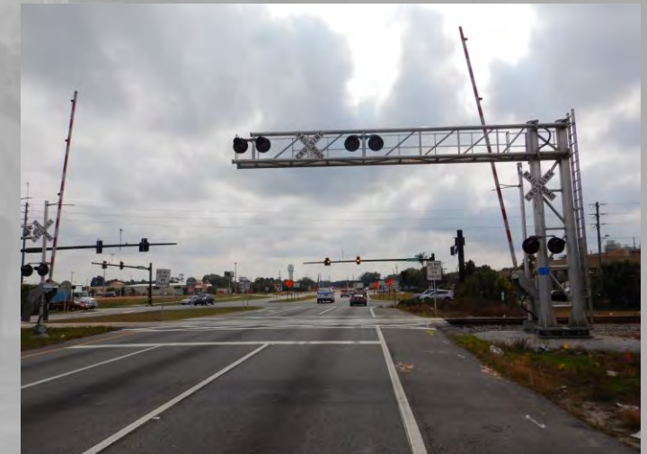
South Poinciana Boulevard (S.B.)
