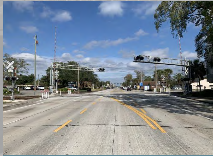
US 17-92 / S. Orlando Avenue (N.B.)
