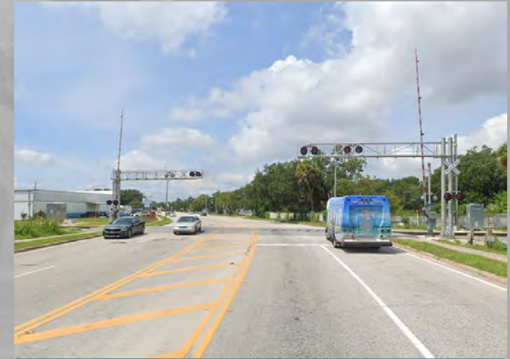
CR-4040 / Fairview Ave (W.B.)
